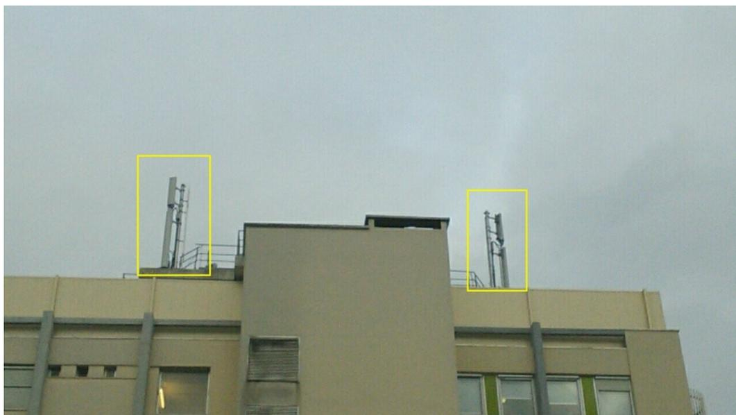
Pour l'identification du point de mesure, l'analyse du site a conduit à effectuer des relevés intermédiaires à une hauteur de 150 cm pour déterminer le point d'amplitude de champ maximale et des points d'intérêts particuliers notamment les lieux accessibles au public.
